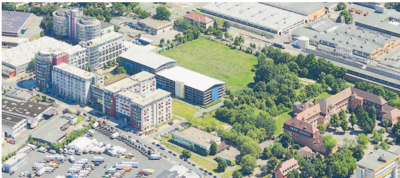
Zwischen dem denkmalgeschützten Fachoberschulgebäude (rechts) und dem „Delu-Zylinder“-Komplex (li.) ist an der Neumeyerstraße das High Tech Center Nord entstanden. Rechts daneben wird ab Sommer Teil drei gebaut. Foto: Oliver Acker, www.digitale-luftbilder.de
