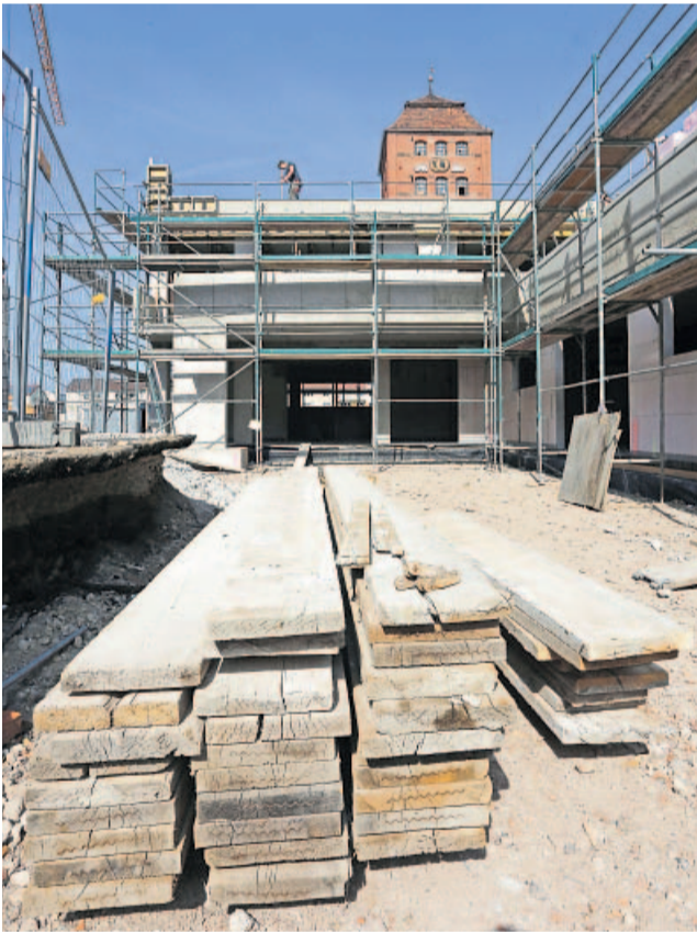
Sonnenschein auf dem Bau, auch im Winter. Foto: Fengler
